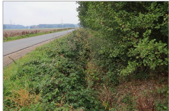
Abb. 5-6: Grabenstruktur zwischen Waldfläche und Straße „Im Hackemoor“ (09/2025)
