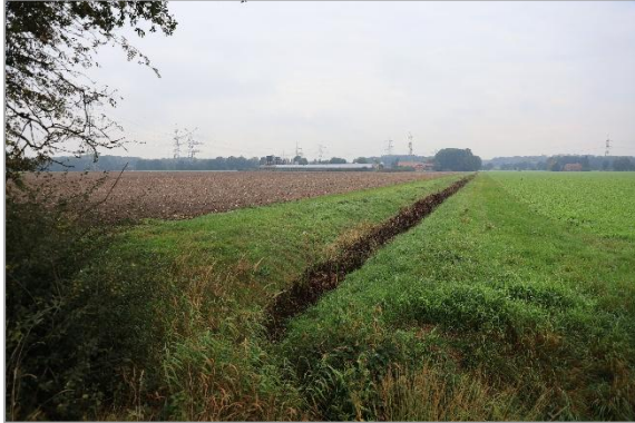
Abb. 5-3: Blick auf den Moorgraben von Süden (09/2025)
