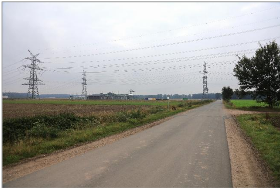
Abb. 5-5: Blick die Straße „Im Hackemoor“ in Richtung Süden östlich des Plangebietes (09/2025)
